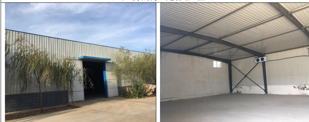
B-3 厂房厂房大门及内部
