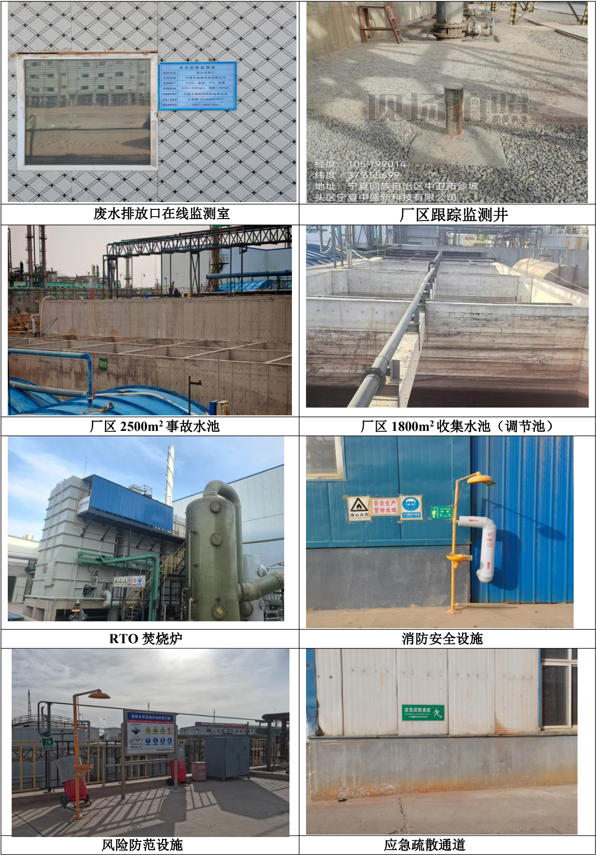
图 2.2-1 厂区部分已建工程照片
