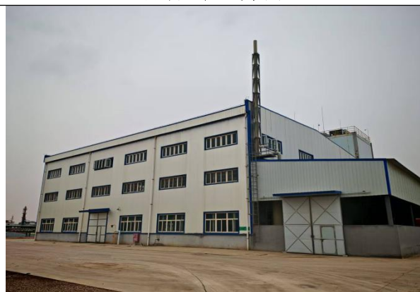
染料一期生产车间
