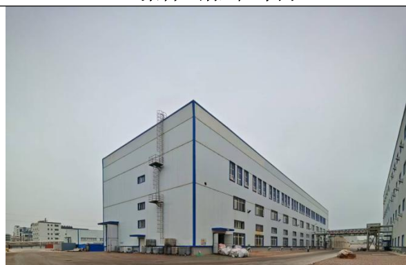
染料二期过滤车间
