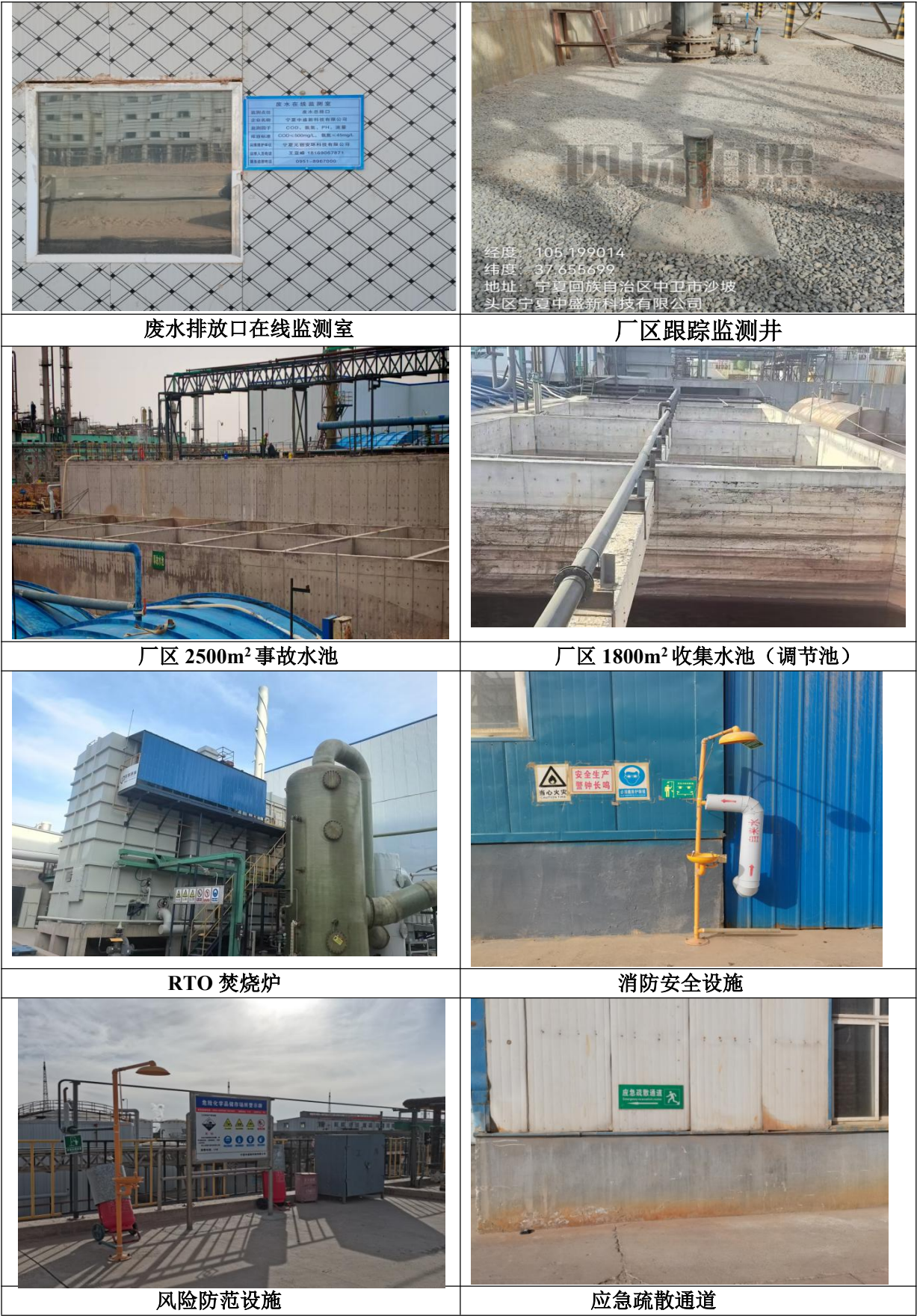
图 2.2-1 厂区部分已建工程照片
