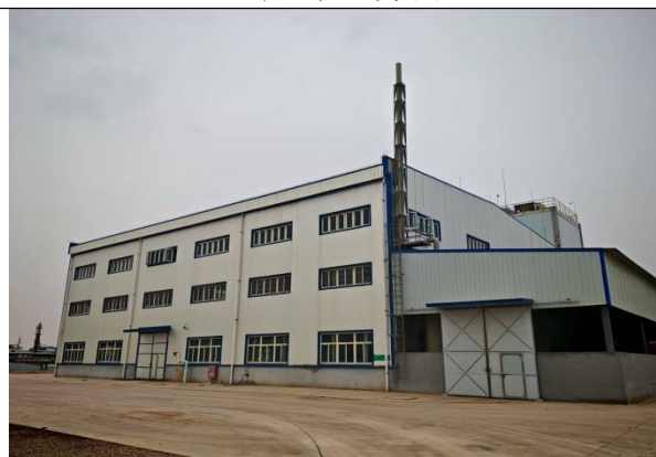
染料一期生产车间
