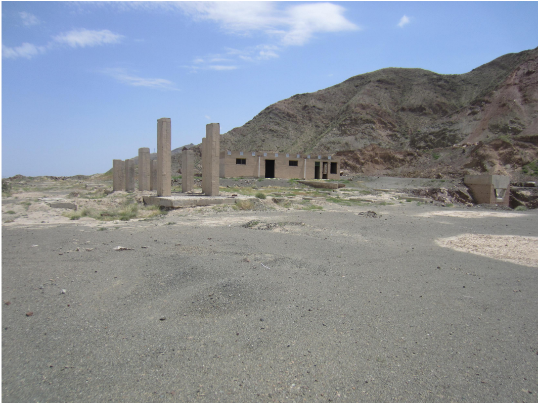
照片 1-2 工业场地照片（正东）
