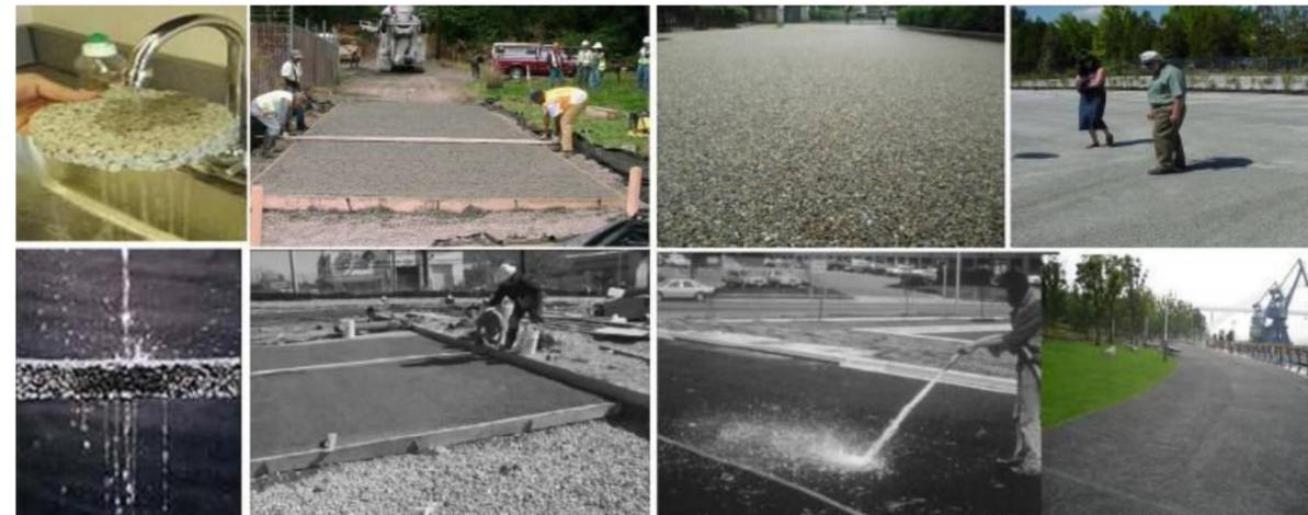
图 6-8 透水混凝土和沥青铺装示意图
